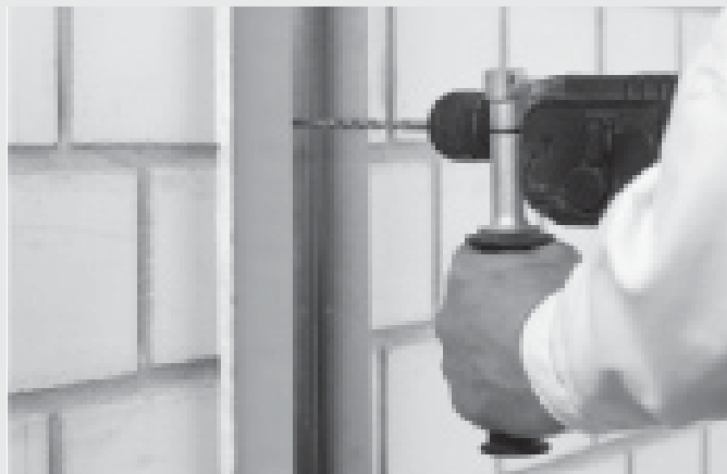
Befestigung der CW-Profile an Massivwand auf Dämmstreifen
