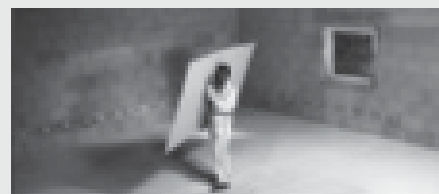
Einzelne fermacell Gipsfaser-Platten hochkant tragen
