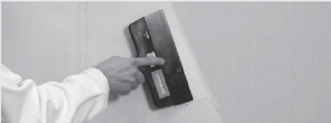
Flächenspachtelung von fermacell Gipsfaser-Platten
