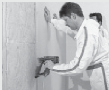
Beplankung der Holzunterkonstruktion mit Klammern
