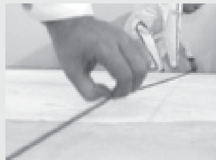
Anlegen der Wandachse mit Schnurschlag oder Hochbaulaser
