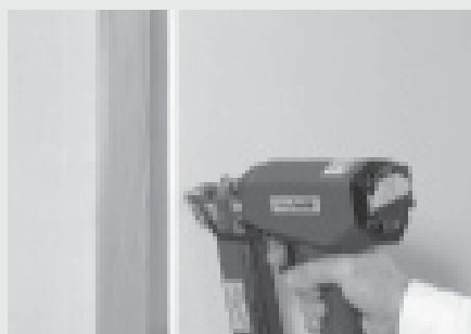
Klammern auf Holzunterkonstruktion
