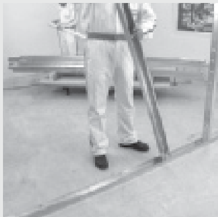
Montage der CW-Ständerprofile
