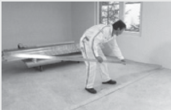
Auslegen der UW-Anschlussprofile am Boden auf Dämmstreifen
