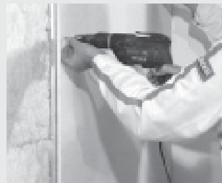
Ansetzen des Schnellbauschraubers
