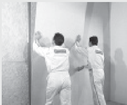
Beplankung der Metallunterkonstruktion
