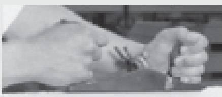
Glatthobeln der Bruchkante von Plattenzuschnitten bei Sichtkanten
