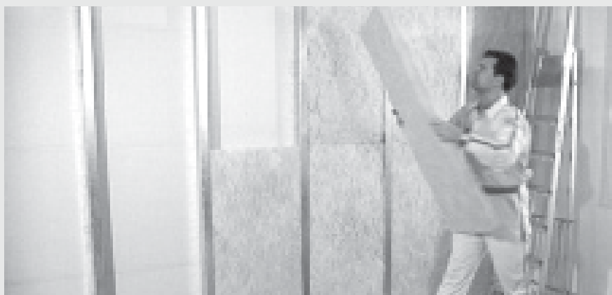
Einbringen der Dämmstoff-Platten
