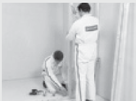
Montage der Holzständer mit Stiftnagel oder Stahlwinkel
