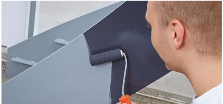
Die Brillux Schaumstoff-Lackierrollen besitzen eine superfeine Porung und ein hohes Einsatzgewicht (55 kg/m<sup>3</sup>), sodass es beim Lackauftrag keinen Materialaufschub und dank minimierter Bläschenbildung ein erstklassiges Finish gibt.
