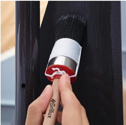
Die Erfahrungen zeigen: Durch Einsatz von Lackierpinseln mit hochwertigen, schwarzen Chinaborsten, wie die Maler-Lackierpinsel 1178 und 1180 von Brillux, werden sehr gute Ergebnisse erreicht. Diese Pinsel verfügen über einen Hohlraum innerhalb des dicht gebündelten Pinselrings, der eine optimale Materialaufnahme und -abgabe gewährleistet. Form und Art der Borste sorgen für ein gleichmäßiges Oberflächenfinish.
