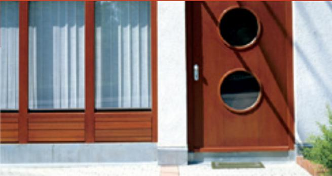
**Maßhaltig** sind Holzbauteile, bei denen Maßänderungen nur in sehr geringem Umfang zugelassen sind, z. B. Fenster, Außentüren und maßhaltig verzapfte und verklebte (verleimte) Fenster- und Türläden.
