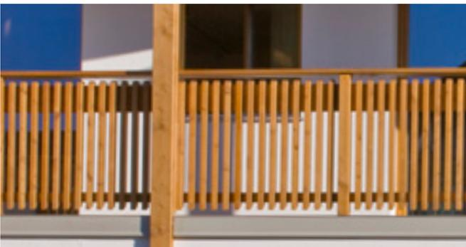
**Nicht maßhaltig** sind Bauteile, deren Volumenänderungen nicht begrenzt sind, also zum Beispiel mit offener Fuge montierte Außenbekleidungen aus Brettern, offene Stülpschalungen auf Lattenrost, überlappende Verbretterungen, Schindeln, Palisaden, Holzroste oder Zäune.
