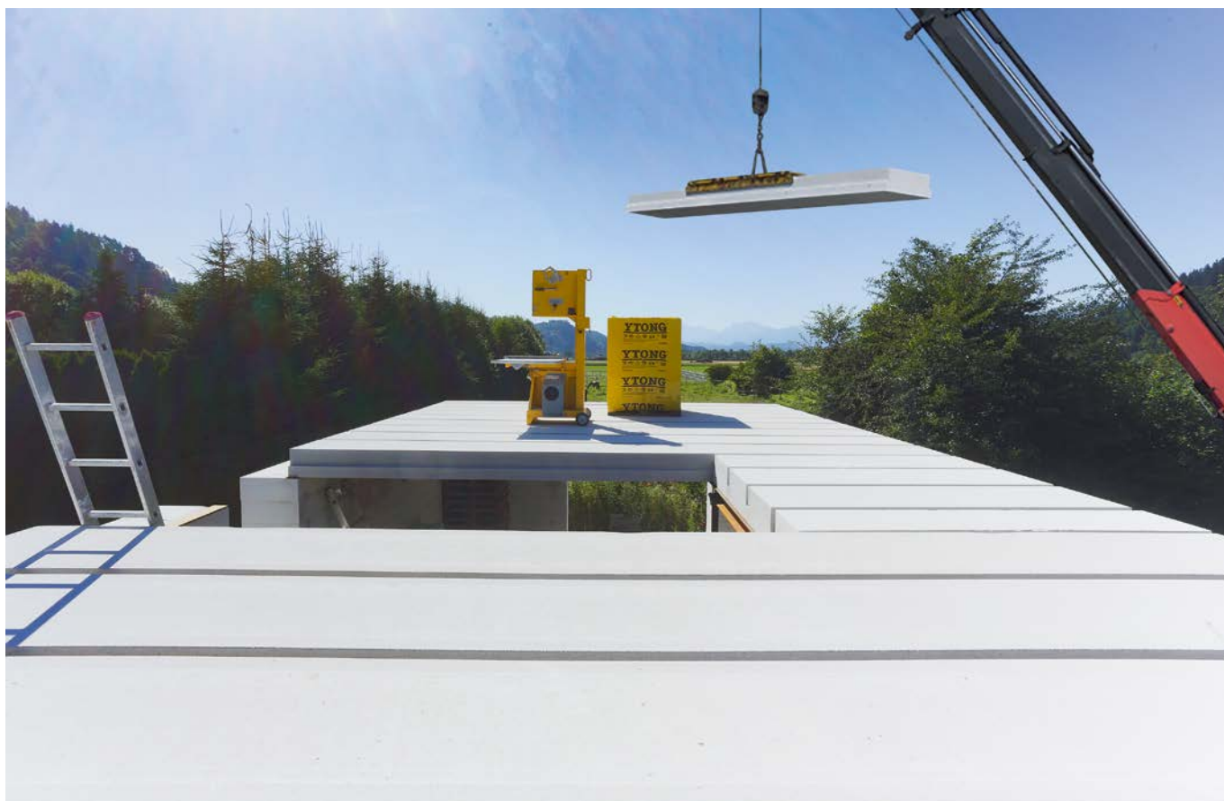
Schnelle Verlegung Ytong Deckenelemente mittels Kran
