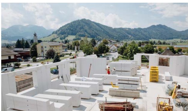
Ytong Systemwandelemente gewährleisten höchste Effizienz: Mit einer Arbeitsgruppe (3 Mann) können bis zu 133 m 2 Wandfläche pro Arbeitstag errichtet werden.
