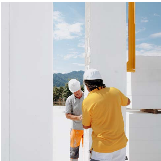
Zur Versetzung der Elemente werden zusätzlich zu dem Kranfahrer lediglich zwei Monteure benötigt.
