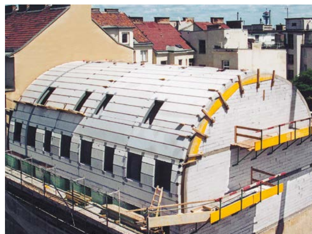
Mit Ytong lassen sich auch komplexe Dachformen realisieren
