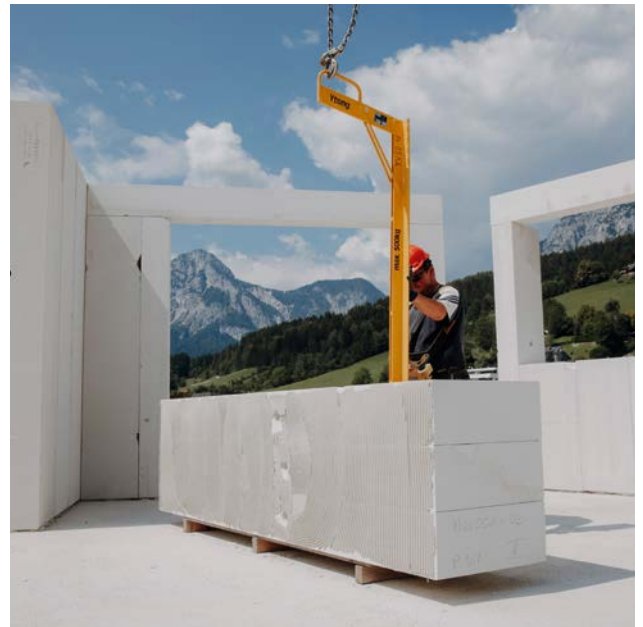
Zur Verarbeitung der Elemente wird Dünnbettmörtel seitlich aufgebracht.
