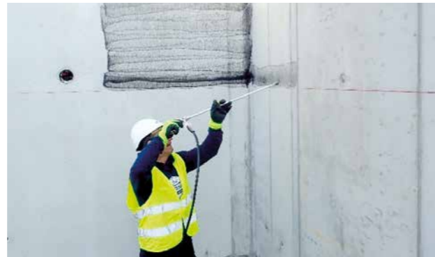
AUFSPRÜHEN VON FG 35 AUF DIE BETONOBERFLÄCHE
