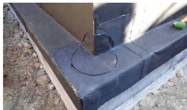
ECKAUSBILDUNG MIT ZUSCHNITTEN AUS BAHNEN
