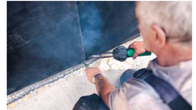
VERSCHWEISSEN DER BAHNEN MIT EINEM HEISSLUFTFÖN
