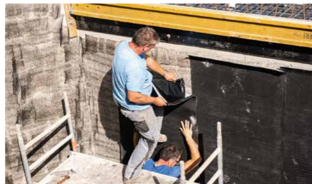
ANSETZEN UND AUSRICHTEN DER BAHN
