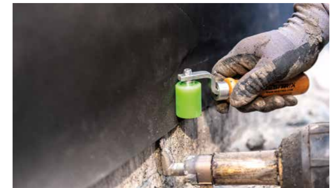
ANSCHLUSS AN BODENPLATTE MIT WINKELDÜSE
