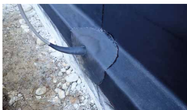
ABDICHTUNG EINER ERDUNGSFAHNE MIT FORMTEIL
