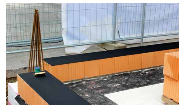
RESITRIX® CL ALS MAUERSPERRBAHN
