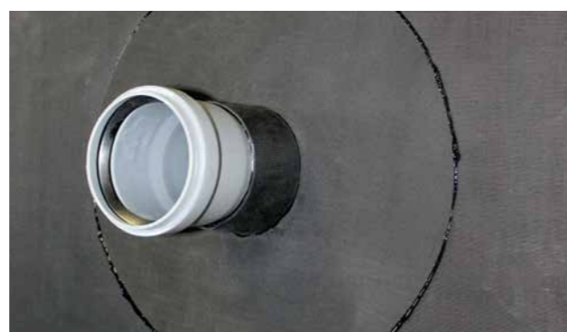
WANDDURCHFÜHRUNG MIT MANSCHETTE AUS BAHNWARE
