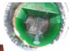
Umwandlungsschacht DN 1000 mit Ein- und Auslauf, mit Prallwand und Entlüftungsöffnung
