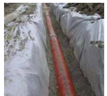
ordnungsgemäße Verlegung PP-MEGA-Drän SN8
