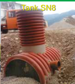
12 m Tank mit 3 Einstiegen, Zuläufe im Einstieg und gedrosseltem Ablauf
